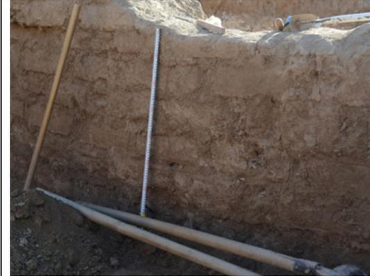
7. 5月6日、部屋8の壁、日干し煉瓦は高さ10cm、横63cm、隙間は3~5mm。
