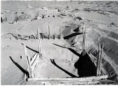
③水室 (FB) (西より)
