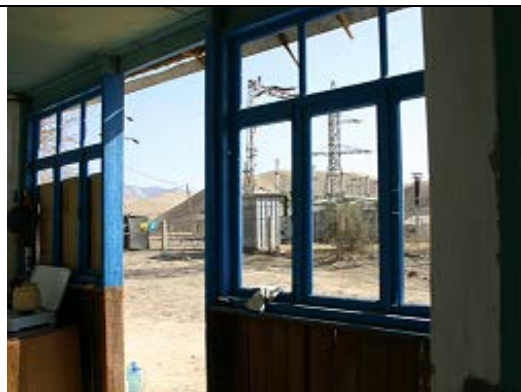
図 1 変電所の横の管理所のような小屋 大形の変圧器から送電線が引かれている 長く住むには向かない環境
